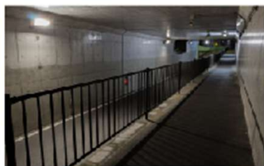
雨水対策事業 (アンダーパス・雨水排水)
