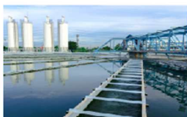
製造業・物流業 (排水処理・タンク・倉庫)
